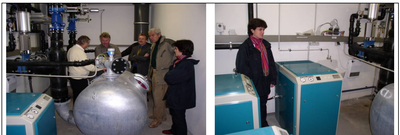
Abbildung 56: Anlage für pneumatischen Abwassertransport
