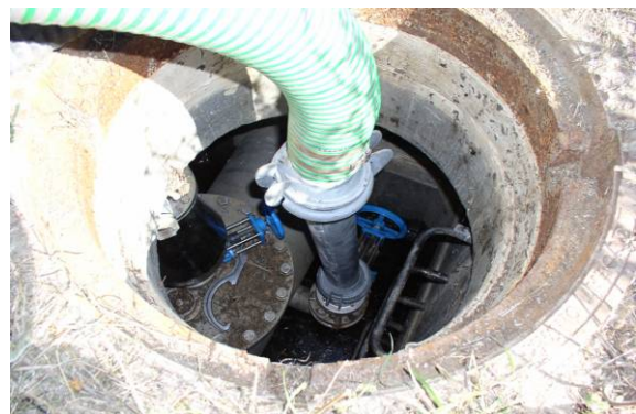
Abbildung 20: Leca Dosierung mit Kanalwagen in Sammler West RHV NSW
