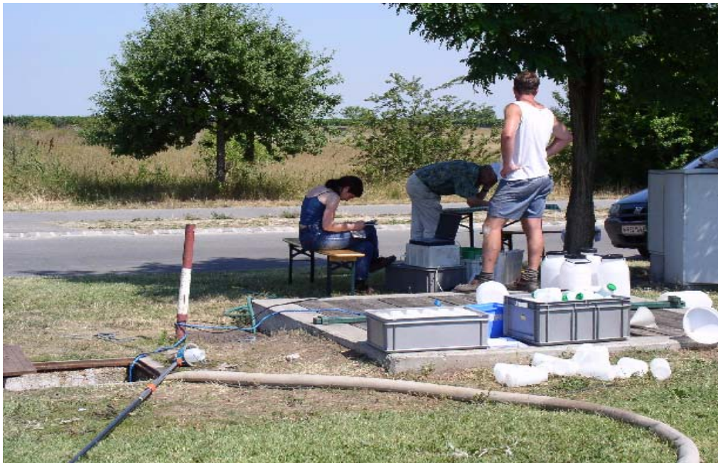
Abbildung 13: Übergangsschacht von Druck- in die Freispiegelleitung mit Biofilteranlage in Illmitz, AWV Seewinkel
