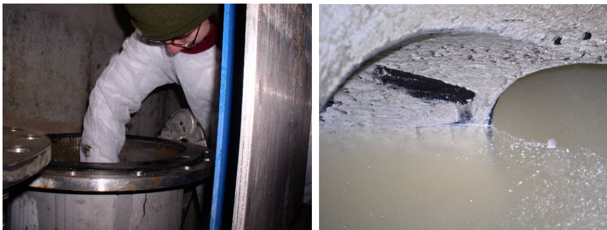
Abbildung 49: Sielhautentnahme für molekularbiologische Untersuchungen
