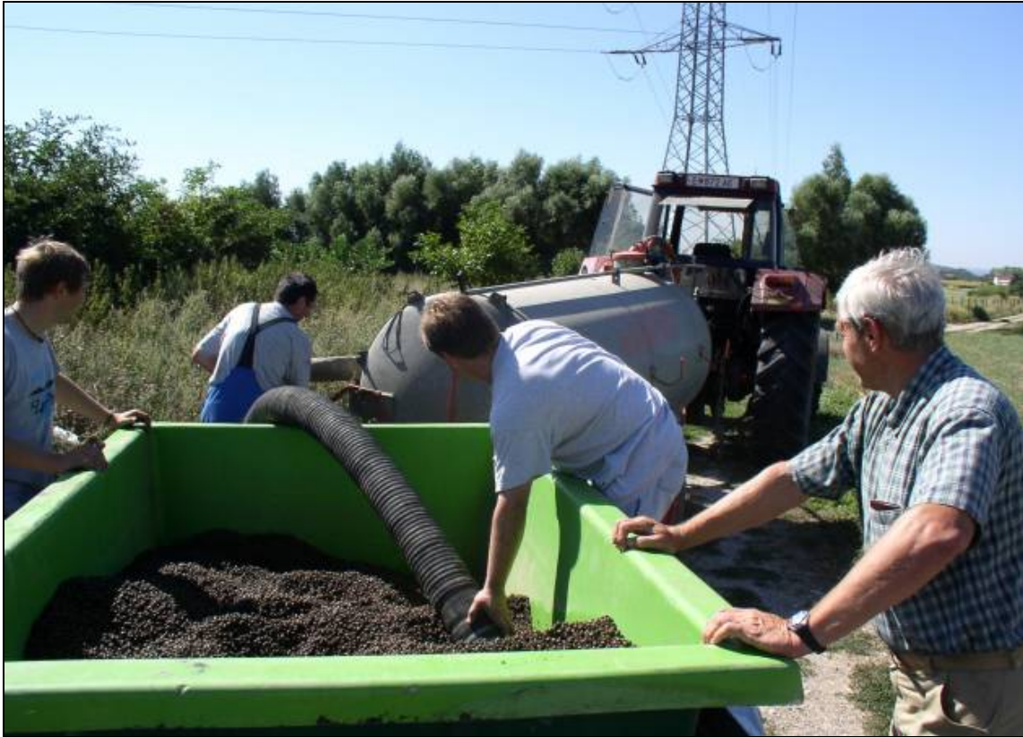
Abbildung 19: Dosierung von Leca mit Güllefass beim Sammler Nord, RHV NSW
