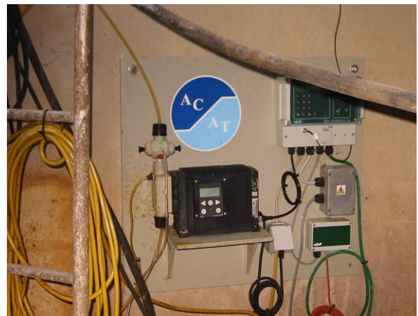
Abbildung 39: Skizze Druckleitungen des AWV Seewinkel (Li.) und Dosiereinheit für Anaerite (Re.)
